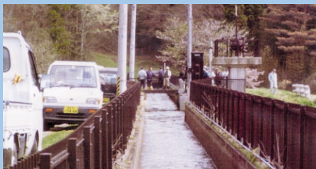
通水初日、水路を見廻り、ゴミ、土砂を排除しながら配水監視する看護人、地元関係者。
