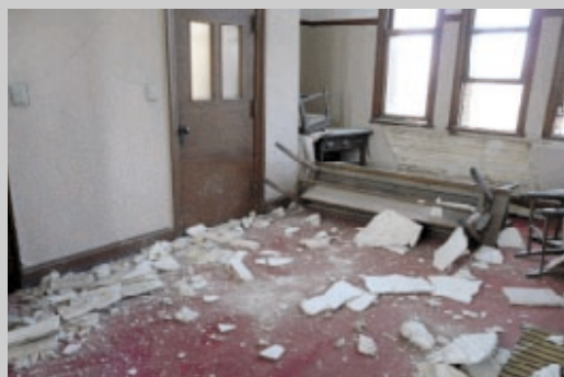
安 積 疏 水 貴 賓 館 内
