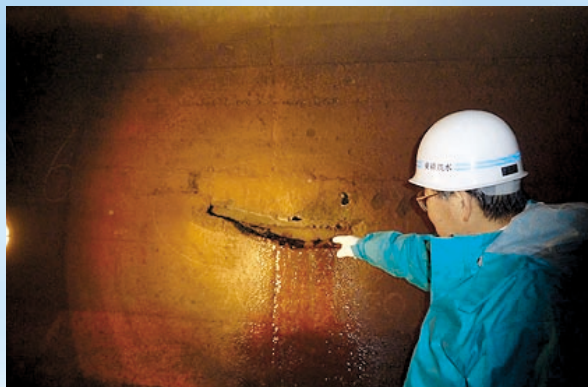
上流部水路側壁の陥没
