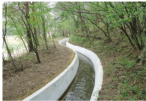
県営用排水施設整備事業 青田地区
