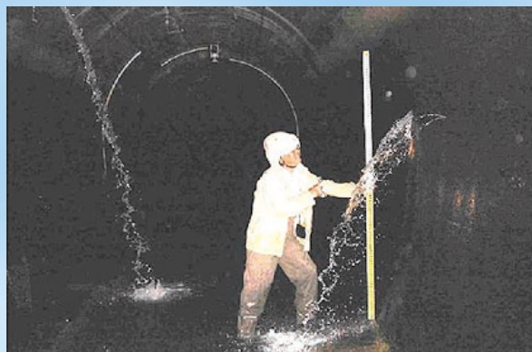
上流部水路亀裂部からの漏水
