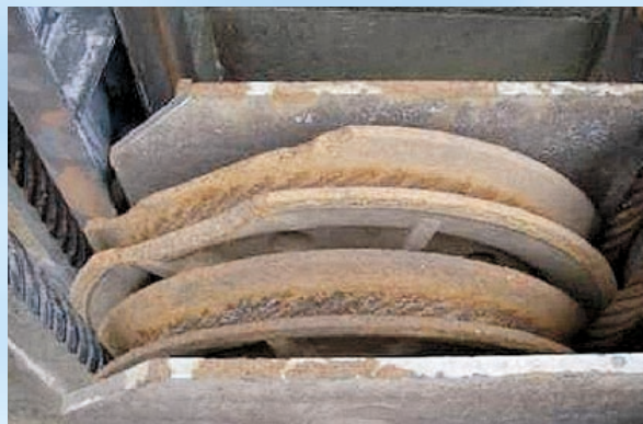
破損している上戸頭首工の滑車
