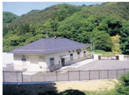
▲小水力発電施設
