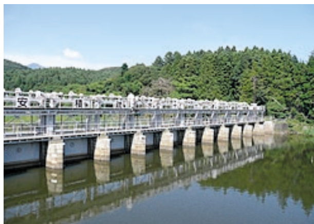
安積疏水十六橋制水門
